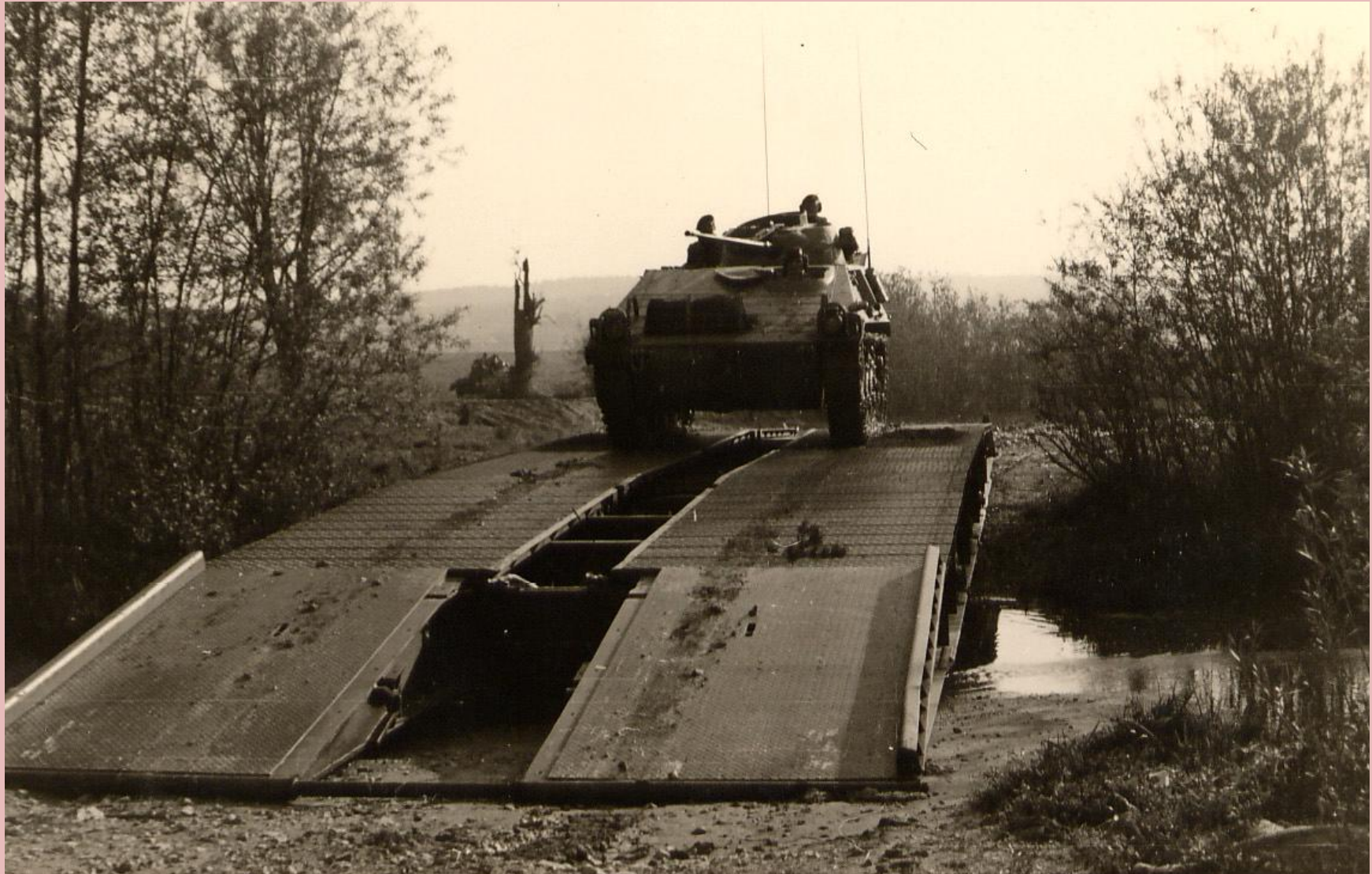
Ein Hotchkiss-Kurz des Brigade-Spähzuges beim Befahren einer Kriegsbrücke.
