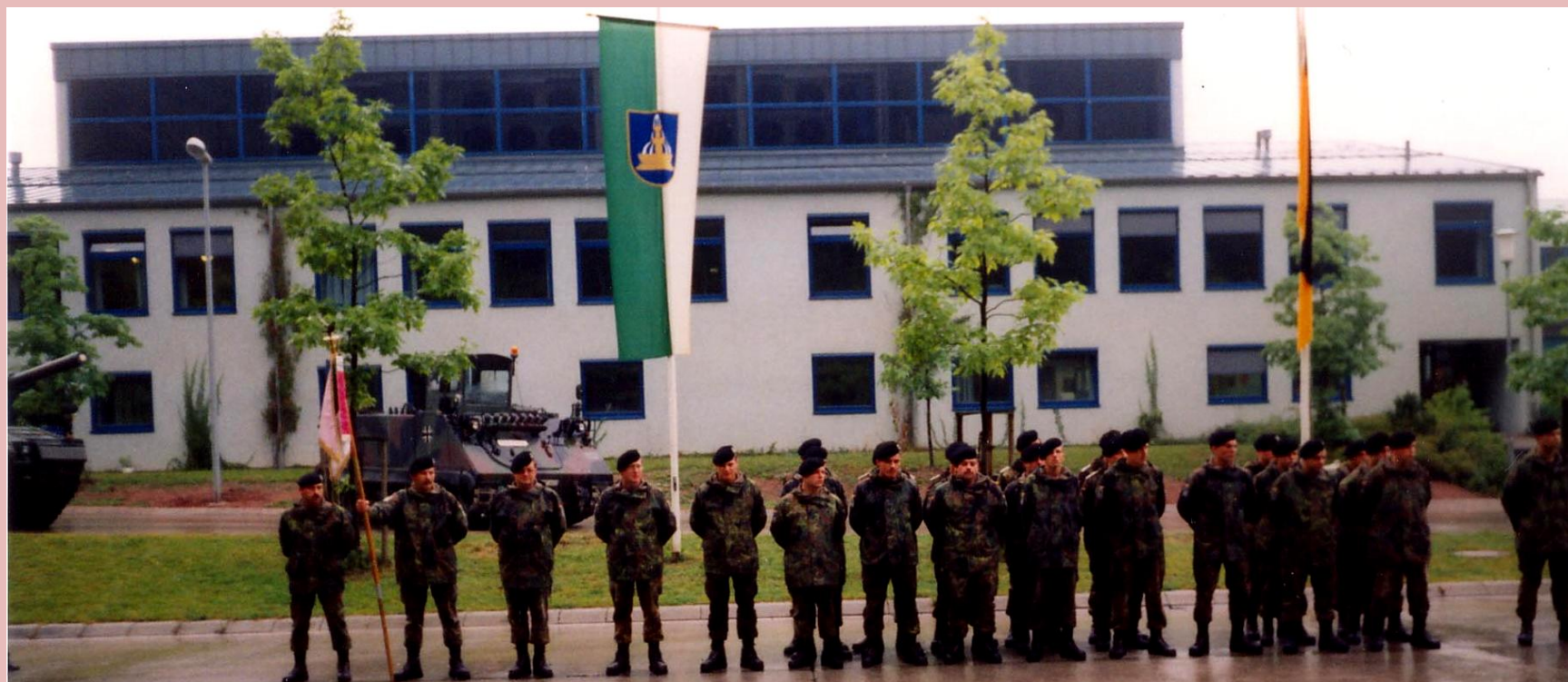
Das Lehrsaal- und Fahrsimulatorgebäude in der Prinz-Eugen-Kaserne in Kilsheim.
